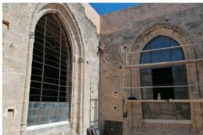
Desmontaje de vidrieras de San Pedro y San Hiscio
